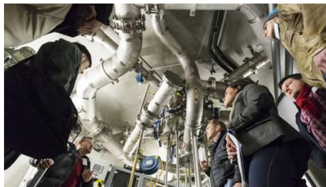
Im Mehrkammerfermenter der PFI Biogasanlage Foto: Energieagentur / Sonja Schwarz
